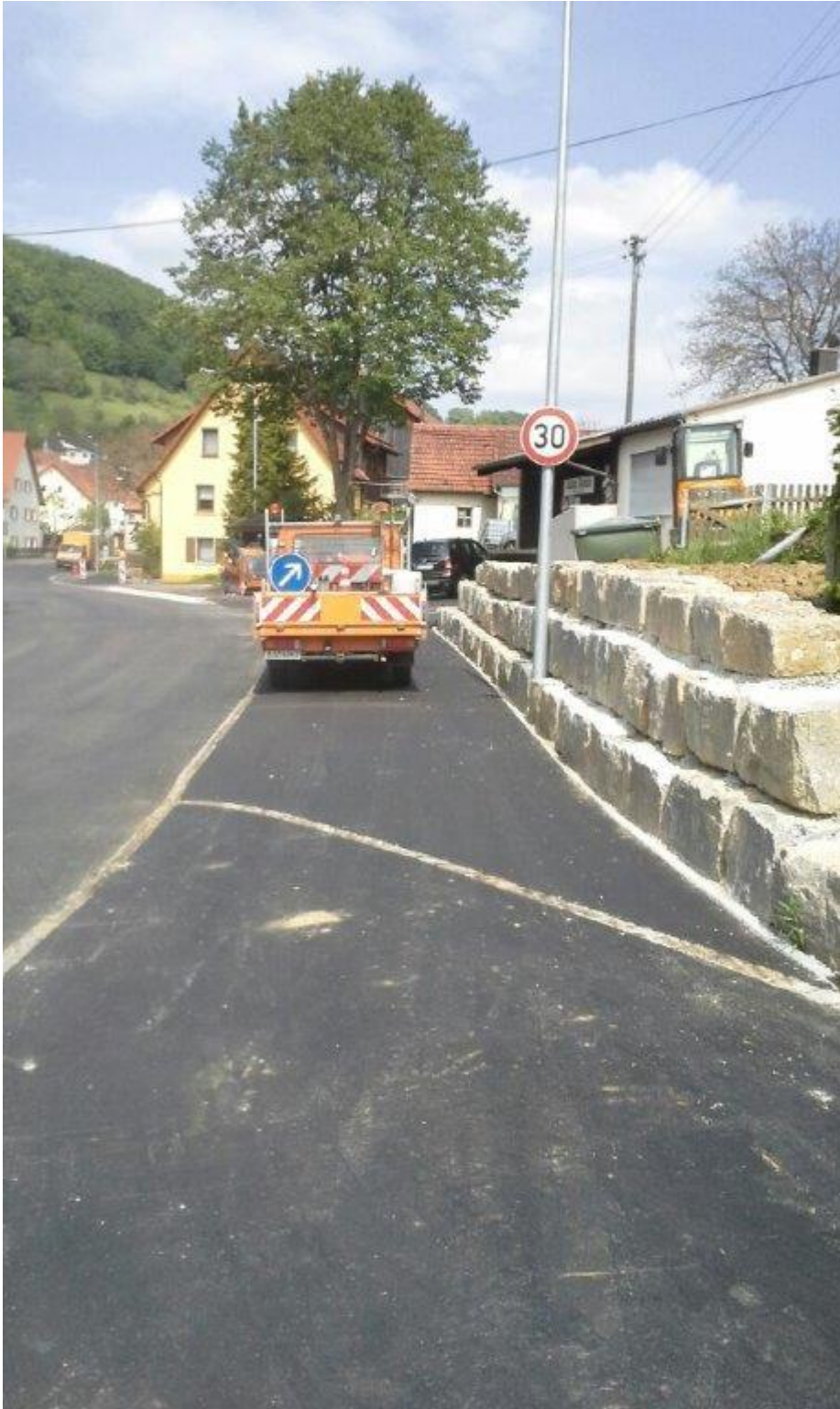
Neue Stützmauer entlang des Bezirksamtes
