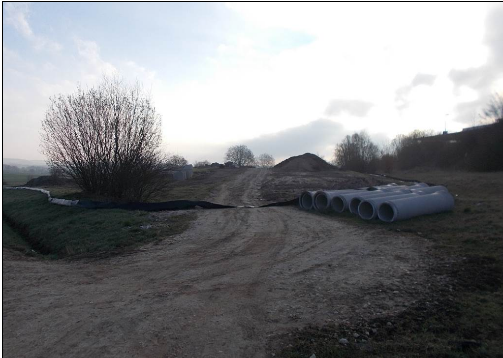
Abb.7: Lagerplatz im Südwesten mit umgebendem Schutzzaun (Aufnahme März 2019)
