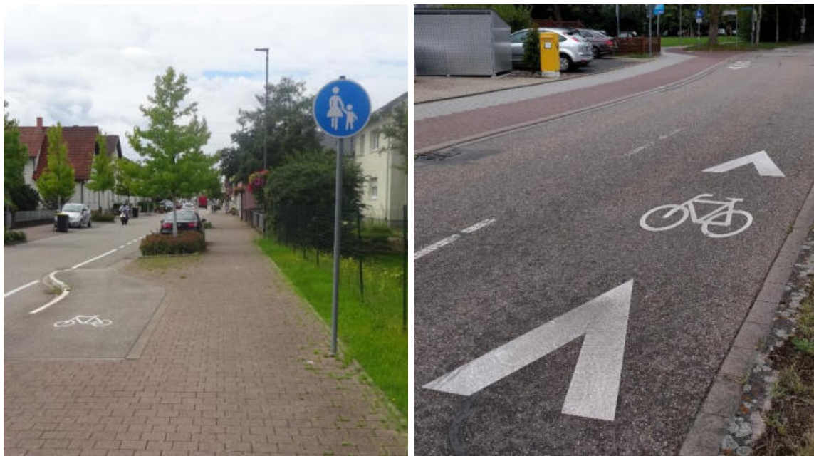
Abbildung 13: Fahrradweiche zur Einleitung auf die Fahrbahn und Piktogramme zur Erinnerung der rechtmäßigen Nutzung der Fahrbahn – links Bietigheim/Baden rechts Rheinstetten
