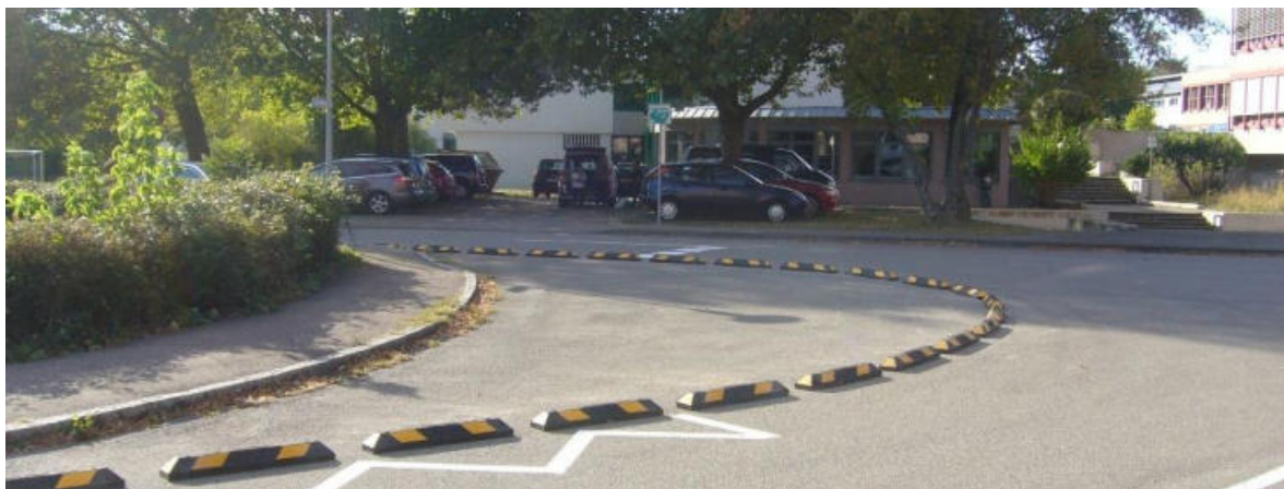
Abbildung 10: baulich temporäre Reduzierung der Querungsdistanz
