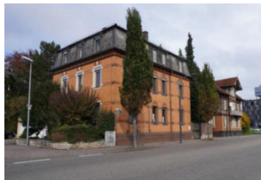
Abbildung 34: Lorcher Straße 20 (Quelle: Landesamt für Denkmalpflege, Schreiben vom 31.10.2024)
