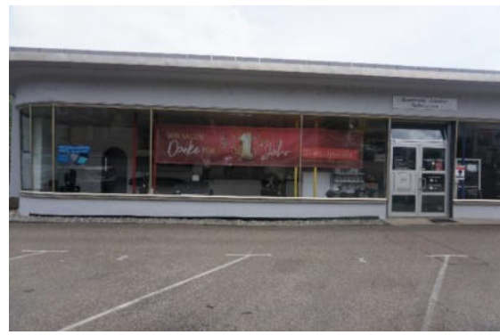
Abbildung 53: Gewerblich genutztes Gebäude modernisierungsbedürftig (Quelle: WHS 2021)
