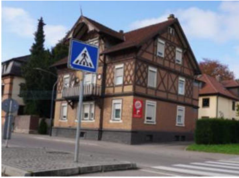
Abbildung 35: Lorcher Straße 22 (Quelle: Landesamt für Denkmalpflege, Schreiben vom 31.10.2024)
