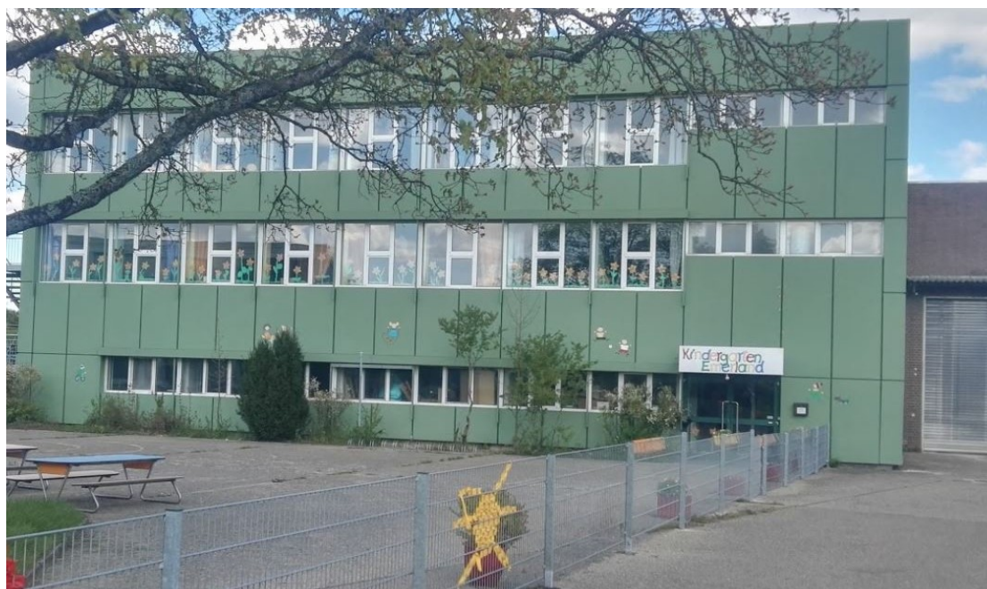
Kindergarten Emerland, Alemannenstraße 69
